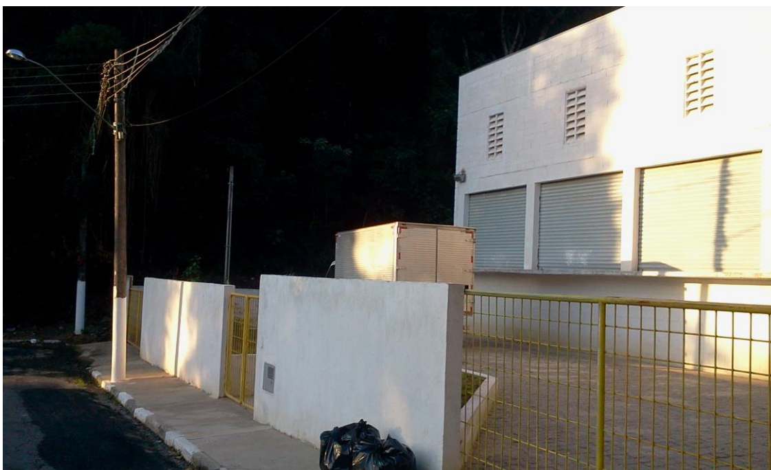
Foto 3 - Galpão de Triagem comparativamente à altura das docas e do caminhão utilizado na coleta de recicláveis
