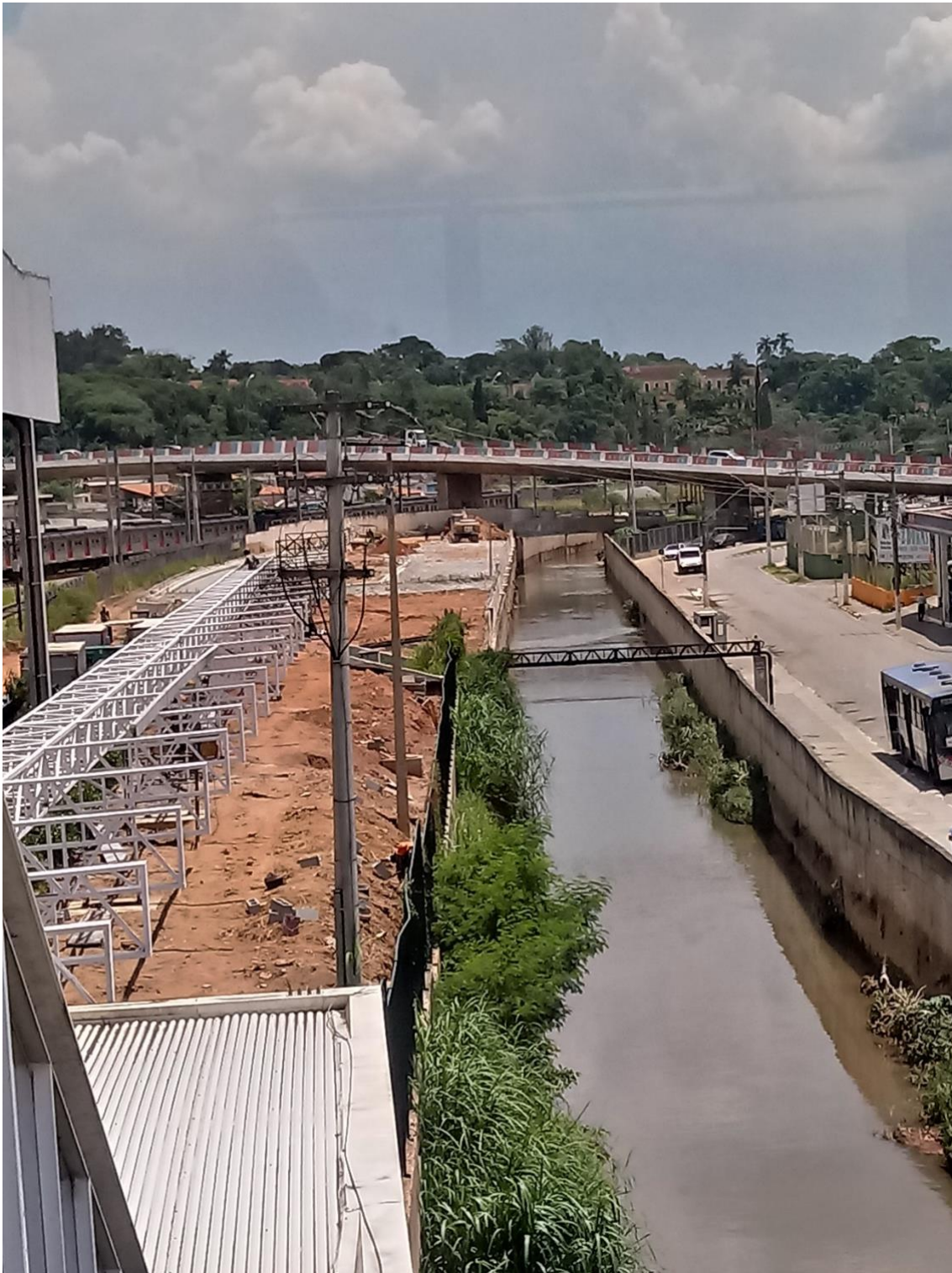
Figura 50: Obras do novo Terminal de Ônibus Oeste conferirá organização e eficácia ao transporte coletivo municipal.
