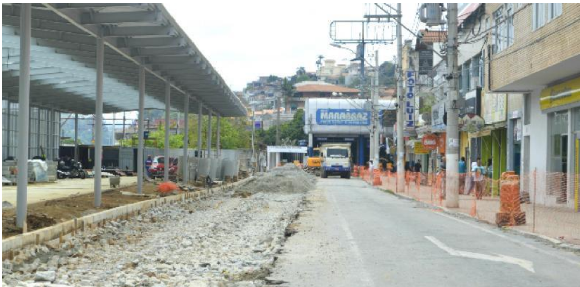
Figura 80: A regulamentação da circulação, cargas e descarga de mercadorias é fundamental para a mobilidade urbana e para o comércio local. Foto de obras também indicam a necessidade de sinalização especial durante sua execução.
