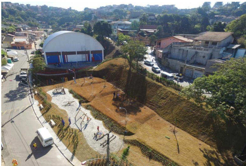
Figura 5: A acessibilidade deve estar presente nos empreendimentos públicos e privados. (Fonte: Google 2018)
