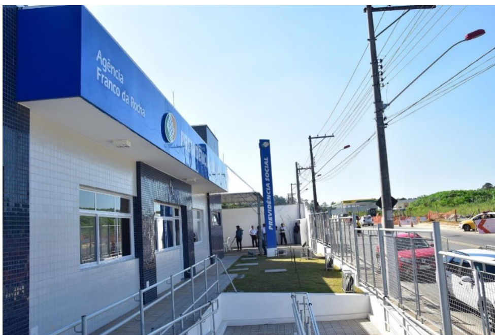
Figura 9: Agência da previdência social em Franco da Rocha já adequada à acessibilidade, conforme legislação.
