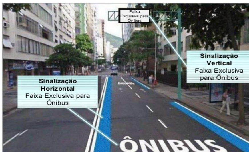
Figura 90: Sinalização de faixa exclusiva para ônibus. (Fonte: Fetranpor 2011)
