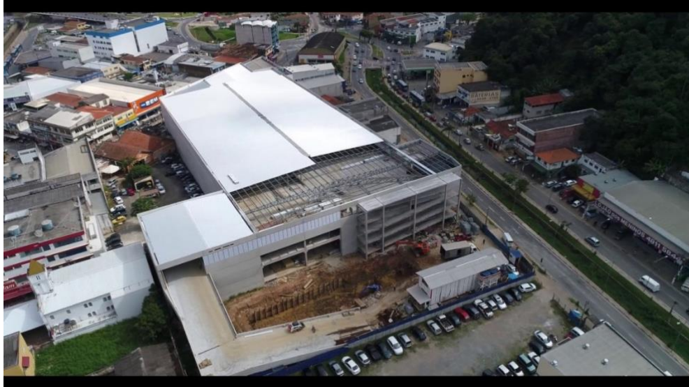
Figura 11: Exemplo de polo gerador de tráfego em construção que demanda uma série de mitigações, adequando o sistema de viagens geradas na cidade de Franco da Rocha. (Fonte: Google 2018)
