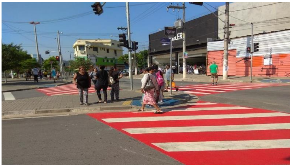
Figura 13: Sinalização de faixas de pedestres em destaque, integradas com rampas acessíveis e semaforização, valorizando as medidas de segurança. (Fonte: Google 2018)
